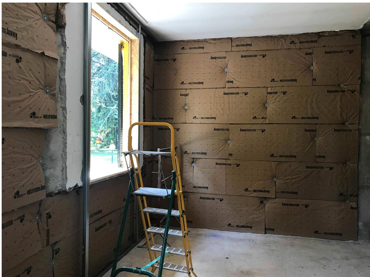
Qui si può vedere la posa dell'isolamento termico - acustico all'interno della parete, prima della chiusura finale mediante pannellature in cartongesso.
